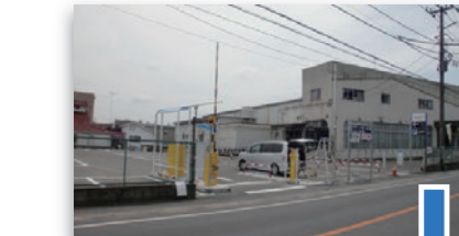
埼玉医科大学病院 外来駐車場 平成29年6月26日開設
