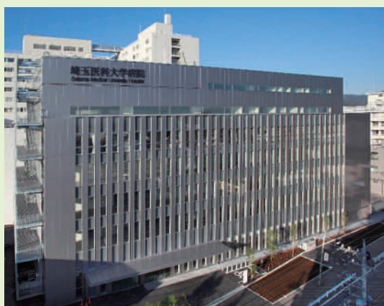
平成28年3月に開院した東館
